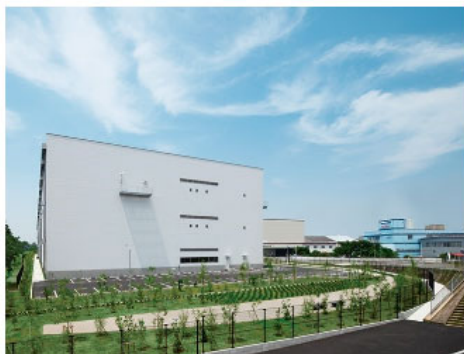
MJロジパーク厚木1
