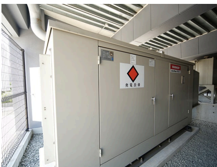
非常用発電機の設置
