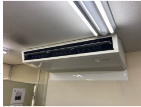
空調設備更新
