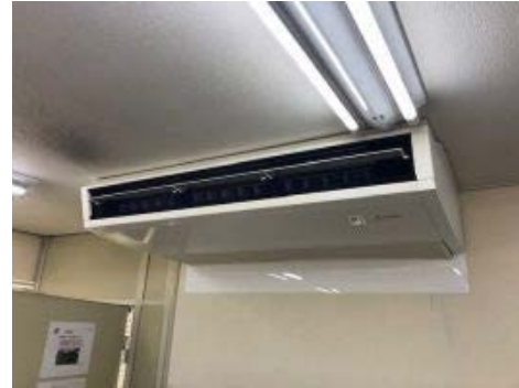
空調設備更新
