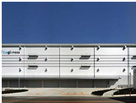
断熱サンドイッチパネルの採用
