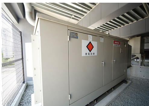
非常用発電機の設置
