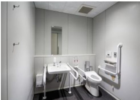
多目的トイレ
