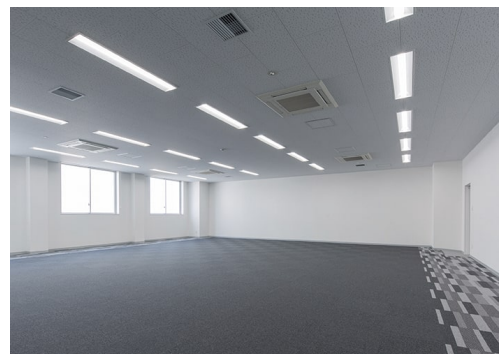
丸の内エリアのオフィスビルにて 使用していたOAフロアパネルを再利用
