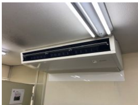
空調設備更新
