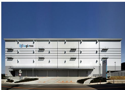
断熱サンドイッチパネルの採用
