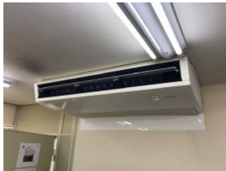
空調設備更新
