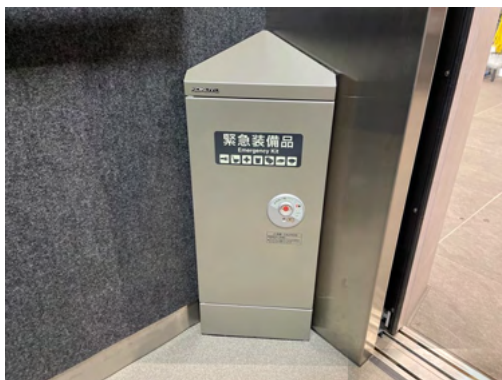
防災キャビネットの設置
