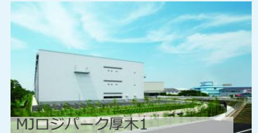
MJロジパーク厚木1
