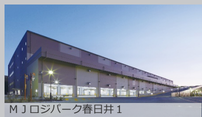
MJロジパーク春日井1
