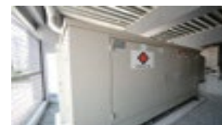
非常用発電設備の設置
