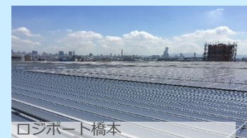
ロジポート橋本
