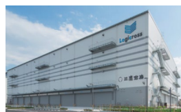
ロジクロス厚木
