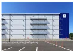
断熱サンドイッチパネルの採用
