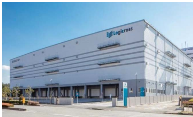
ロジクロス習志野
