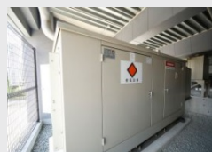
非常用発電機の設置
