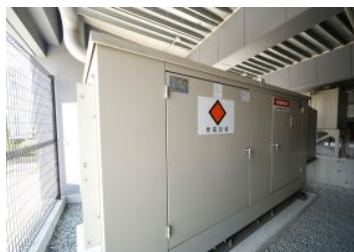
非常用発電機の設置
