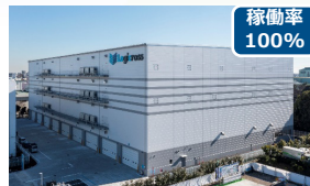
ロジクロス船橋 (23千m 2 ) 2021年竣工
