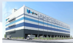
ロジクロス大阪住之江 (43千m 2 ) 2025年竣工予定
