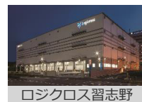
ロジクロス習志野
