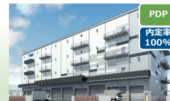
(仮称) MJロジパーク岡崎1 (24千m 2 ) 2023年竣工
