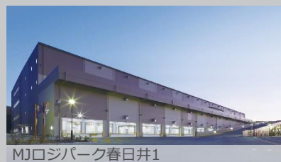
MJロジパーク春日井1
