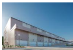
MJロジパーク春日井1
