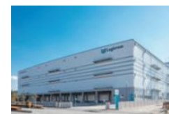
ロジクロス習志野
