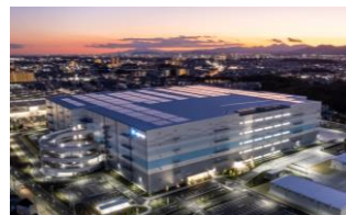
ロジクロス座間
