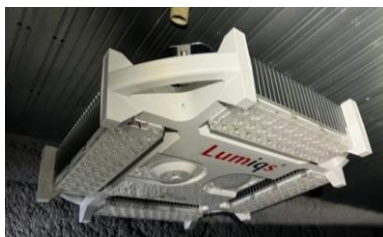
人感センサー付 LED照明の導入
