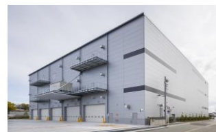
(仮称) MJロジパーク豊中1
