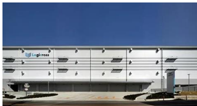
断熱サンドイッチ パネルの採用
