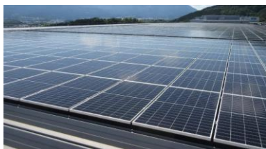
太陽光パネルの設置
