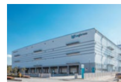
ロジクロス習志野
