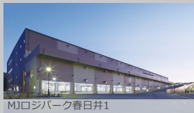
MJロジパーク春日井1
