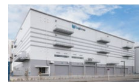
ロジクロス横浜港北
