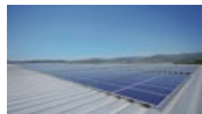
太陽光パネルの設置
