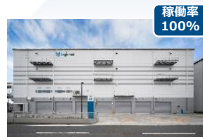
ロジクロス横浜港北 (16千m 2 ) 2019年竣工
