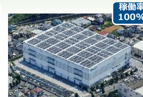
ロジクロス厚木Ⅱ (35千m 2 ) 2019年竣工
