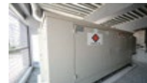
非常用発電設備の設置
