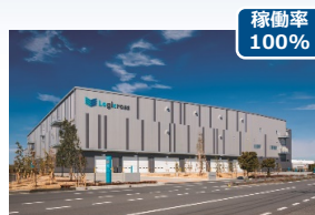
ロジクロス蓮田 (79千m 2 ) 2021年竣工
