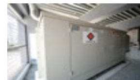
非常用発電設備の設置
