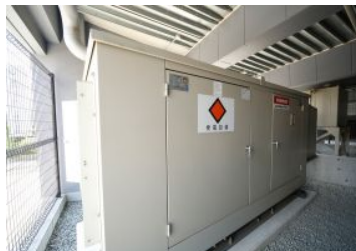
非常用発電機の設置
