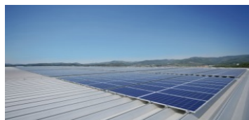
太陽光パネルの設置
