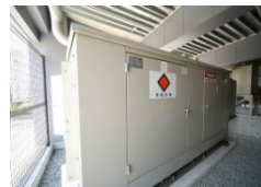
非常用発電機の設置
