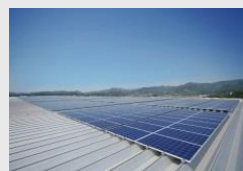
太陽光パネルの設置
