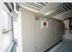
非常用発電機の設置
