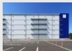
断熱サンドイッチパネルの採用
