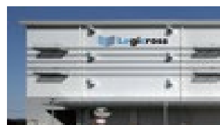
断熱サンドイッチパネルの採用
