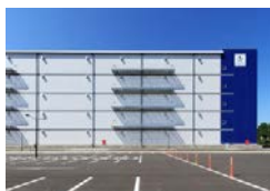
断熱サンドイッチパネルの採用
