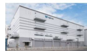
ロジクロス横浜港北
