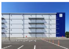
断熱サンドイッチパネルの採用
