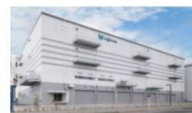
ロジクロス横浜港北
