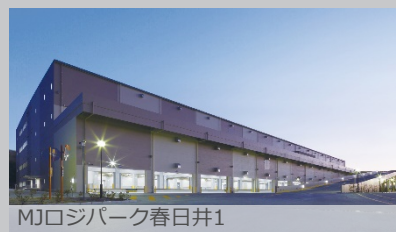
MJロジパーク春日井1
