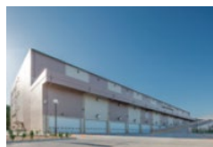
MJロジパーク春日井1
