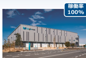
ロジクロス蓮田 (79千m 2 ) 2021年竣工
