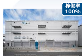
ロジクロス横浜港北 (16千m 2 ) 2019年竣工
