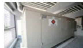
非常用発電設備の設置
