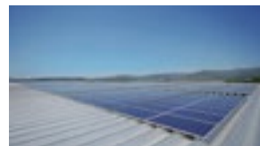
太陽光パネルの設置
