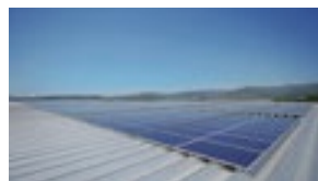
太陽光パネルの設置
