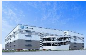
（仮称）ロジクロス座間 (183千㎡) 2023年竣工予定
