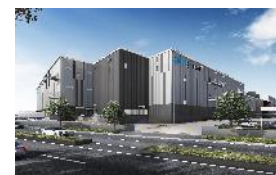
（仮称）ロジクロス蓮田 (79千㎡) 2021年竣工予定
