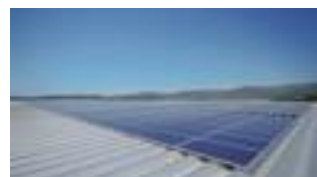
太陽光パネルの設置
