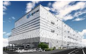
（仮称）ロジクロス春日部 (39千㎡) 2021年竣工予定
