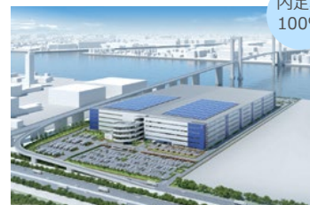
ロジポート川崎ベイ (296千m 2 ) 2019年度竣工 (共同開発)
