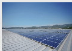
太陽光パネルの設置
