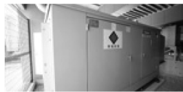
非常用発電機の設置
