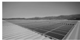
太陽光パネルの設置
