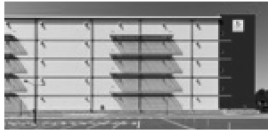
断熱サンドイッチパネルの採用
