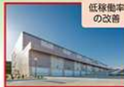
MJロジパーク春日井1 (58千㎡) 2016年度竣工
