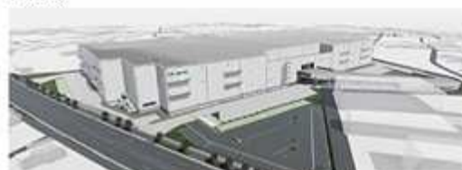
(仮称)ロジクロス蓮田
