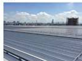
太陽光パネル
