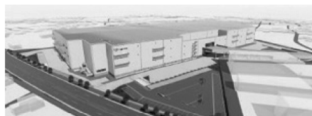
（仮称）ロジクロス蓮田
