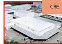
MJロジパーク西宮1 (13千㎡) 1990年度竣工
