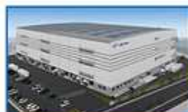
ロジクロス厚木Ⅱ (注4)
