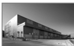
MJロジパーク春日井1
