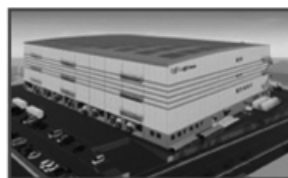
ロジクロス厚木Ⅱ(注1)
