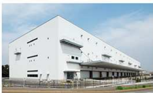
MJロジパーク厚木1
