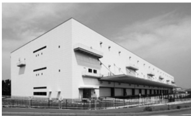
MJロジパーク厚木1
