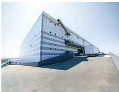
スロープにより3階までトラックが直接接車できるため、高い配送効率を備えています。
