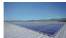
太陽光パネルの設置
