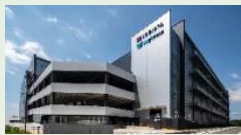
ロジスタ・ロジクロス 茨木彩都A棟 BELS評価 ★★★★★ CASBEE評価 S (不動産)
