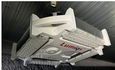
人感センサー付 LED照明の導入
