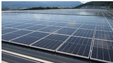
太陽光パネルの設置
