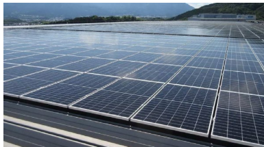
太陽光パネルの設置
