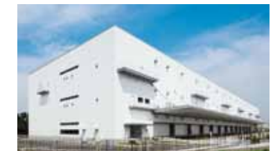
MJロジパーク厚木1
