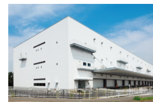
MJロジパーク厚木1
