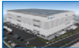
ロジクロス厚木Ⅱ (注7)
