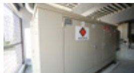
非常用発電機の設置
