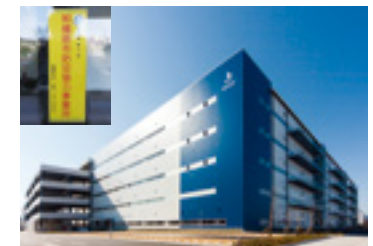
ロジポート橋本・ロジポート相模原
