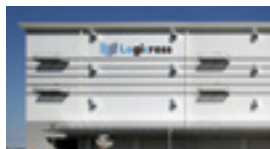
断熱サンドイッチパネルの採用
