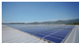
太陽光パネルの設置
