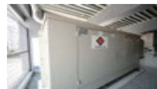
非常用発電設備の設置
