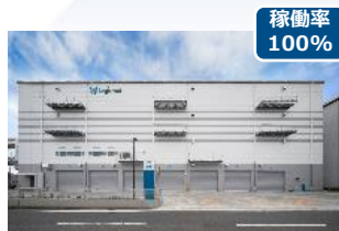
ロジクロス横浜港北 (16千m 2 ) 2019年竣工
