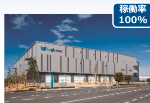
ロジクロス蓮田 (79千m 2 ) 2021年竣工
