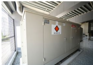
非常用発電機の設置
