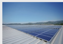
太陽光パネルの設置
