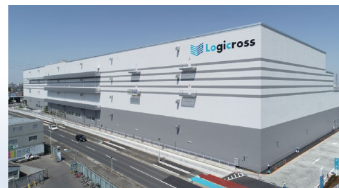
ロジクロス春日部 (38千㎡) 2021年竣工
